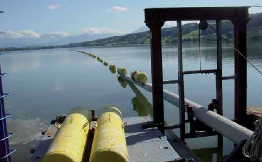
Construction du gazoduc dans le Baldeggersee en direction de Hitzkirch.
