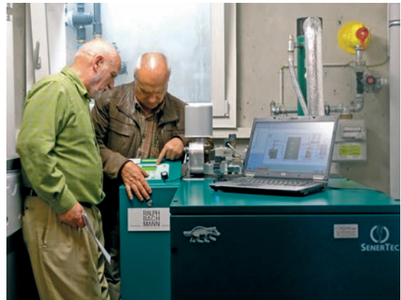
Illustration 5: CCF avec une puissance de 5 kW el et 14 kW th
