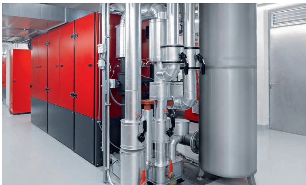
Illustration 1: Une centrale thermique (CCF) avec une puissance de 240 kW el et 365 kW th
